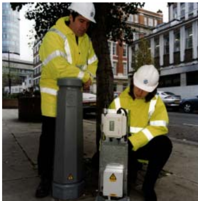
Монтаж типового расходомера AquaMaster™ для измерения расхода в трубопроводах районного водоснабжения
