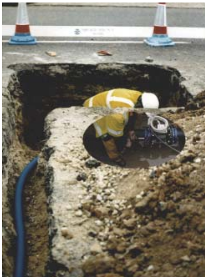
Подземная установка AquaMaster™
